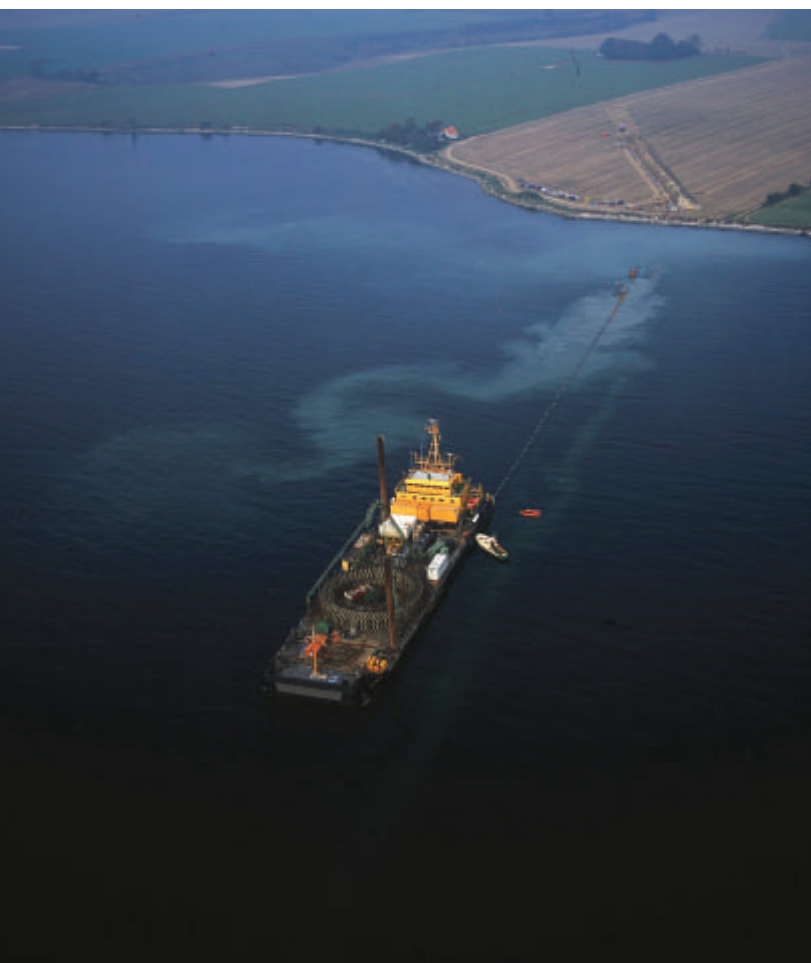
Atlantis i færd med at udlægge søkablet ved Vantore Strand.
